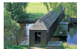
Dřevěný most v Lenoře
