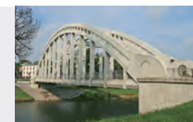
Železobetonový most v Karviné-Darkově
