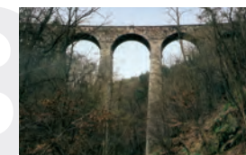
Železniční most v Žampachu
